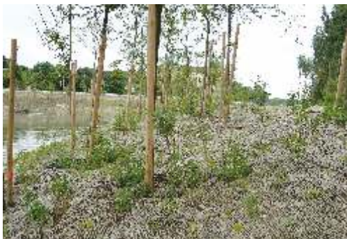
Sifor ® Géofilets en jute posés transversalement par rapport au terrain.
