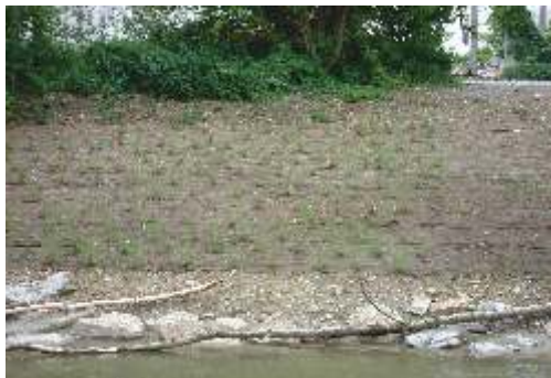
Sifor ® Géofilets en jute posés le long d'un cours d'eau.
