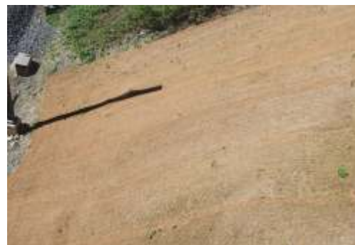
Pose du Sifor® Géofilets en coco.
